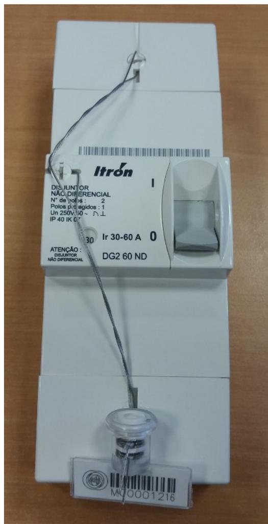
Figura 24 – Exemplo de selagem de DCP instalado em prancheta
