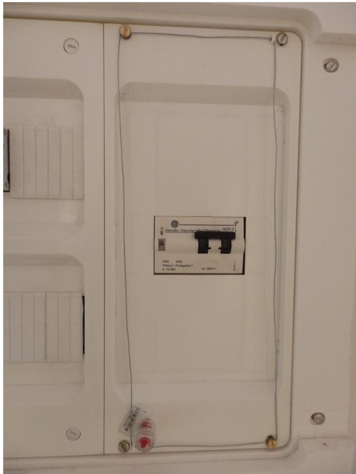
Figura 25 – Exemplo de selagem de DCP instalado no interior do quadro geral do cliente, exceto no caso em que esta selagem impeça o fecho da porta.
