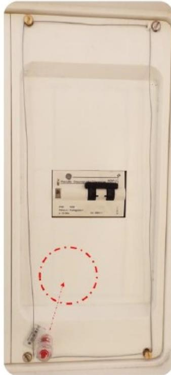
Figura 26 – Exemplo com local de novo posicionamento da selagem de DCP instalado no interior do quadro geral do cliente, quando a selagem normal dificulta o fecho da porta.
