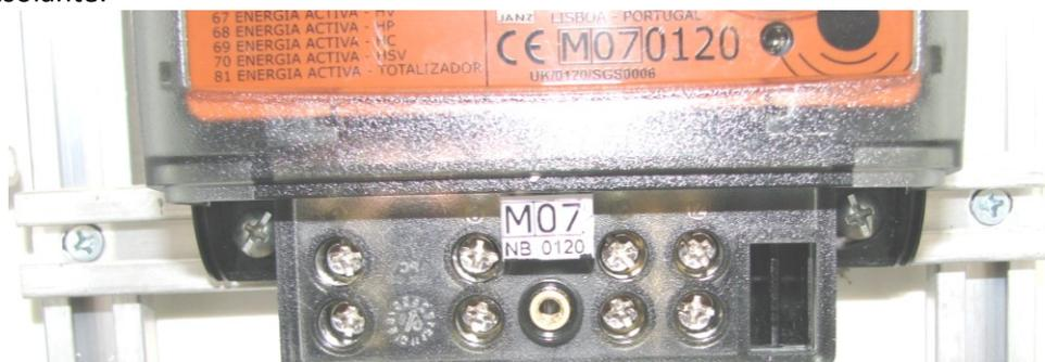
Figura 9 – Fixação inferior em calha metálica
