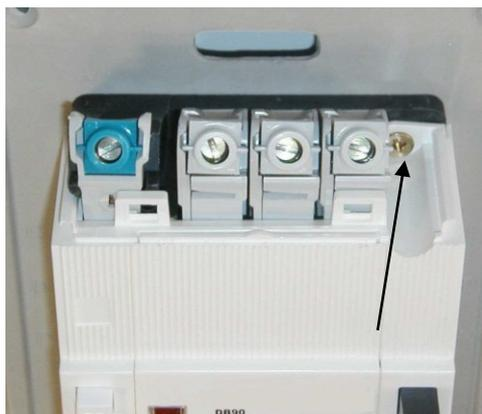
Figura 20 – Fixação na parte superior de um DCP tetrapolar
