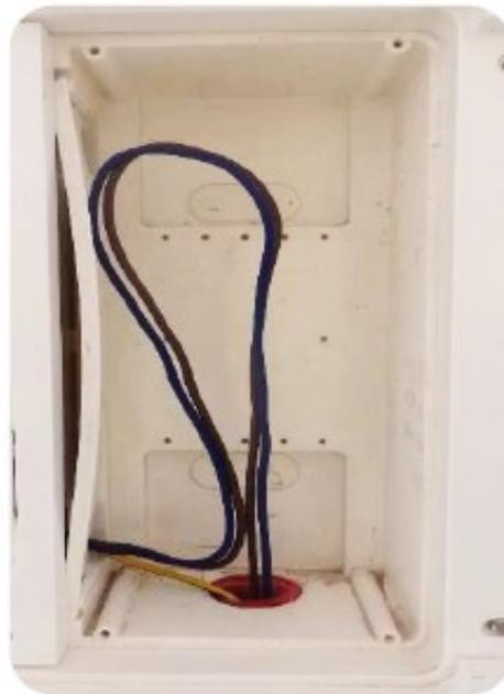
Figura 17 - Exemplo de nova ligação sem cortar os condutores e sem instalar DCP
