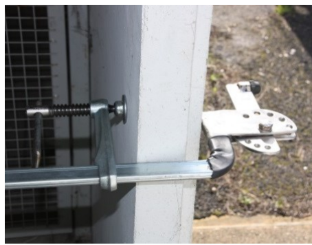
Figura 3 - Vista pormenor interior
