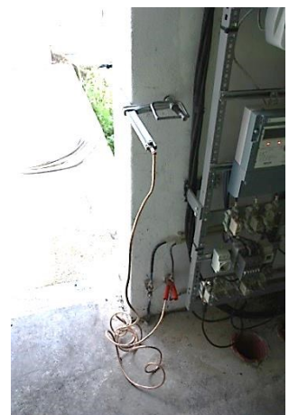
Figura 4 - Ligação à terra de proteção
