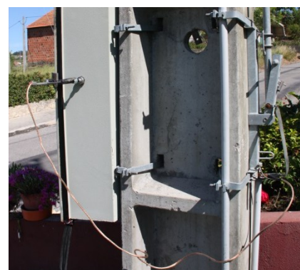
Figura 4 - Ligação à terra de proteção
