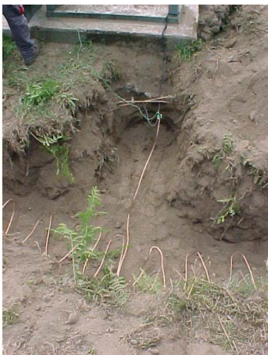
Fig. 41 – Ligação do eletrodo de terra – serpentina dupla longa
