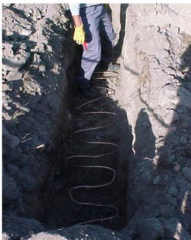
Fig. 39 – Ligação do elétrodo de terra – serpentina simples
