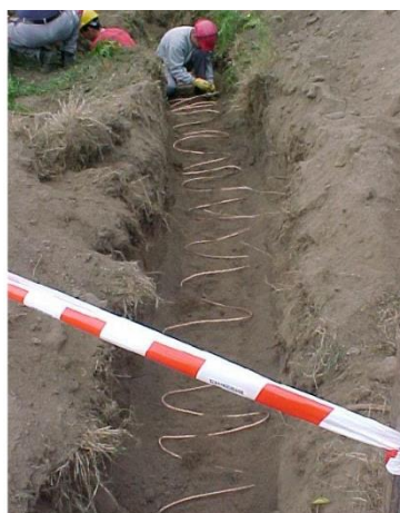
Fig. 40 – Ligação do elétrodo de terra – serpentina dupla
