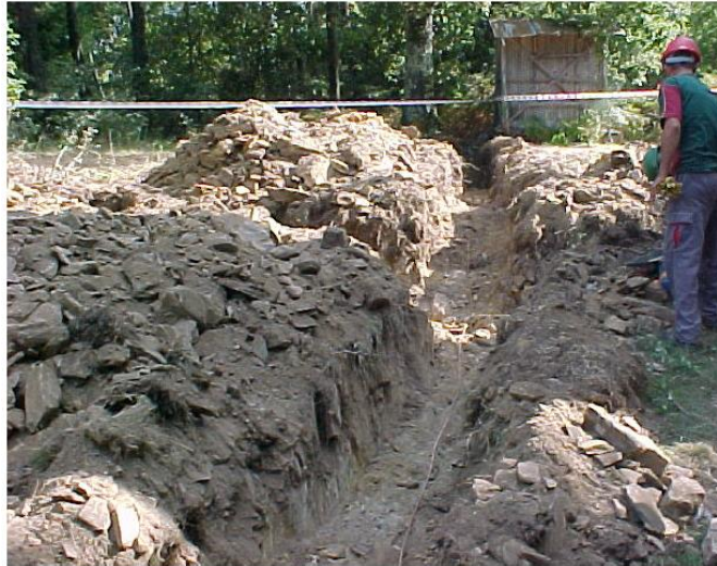
Fig. 42 – Ligação do eletrodo de terra – estrela
