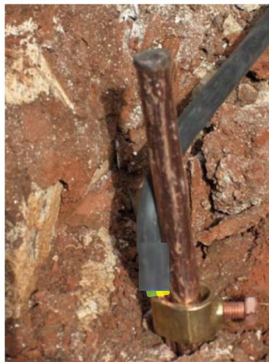
Fig. 37 – Ligação do eletrodo de terra – vareta simples ou extensível
