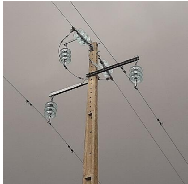
Fig. 4 – TAL-A2S – Exemplo após retirada de uma travessa TAL com fixação R (esq) e RD (drt)
