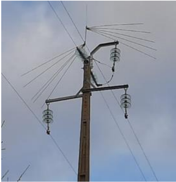
Fig. 4 – TAL-A2S – Exemplo após retirada de uma travessa TAL com fixação R (esq) e RD (drt)
