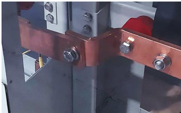
Figura 5.3 – Fotografia exemplo da solução de barramento de neutro
