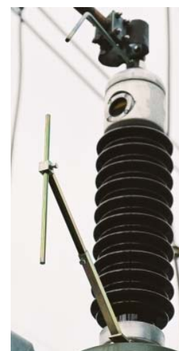
c) Haste de guarda regulável instalada na travessia de 60 kV de um transformador AT/MT
