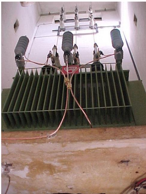
Figura 11 - Exemplo de montagem de DST diretamente na cuba do transformador
