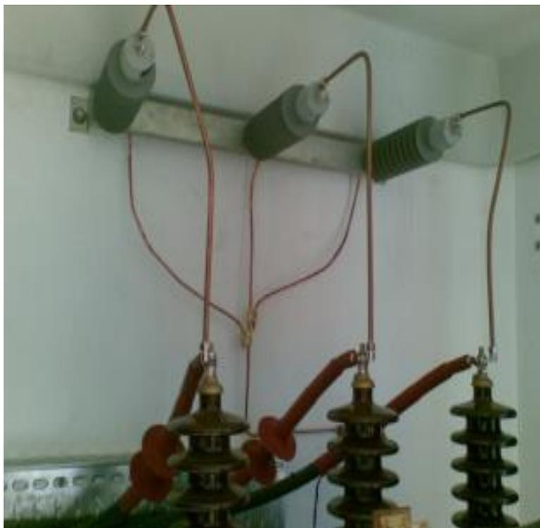
Figura 15 - Montagem de DST no interior de PTCB junto ao transformador (apenas ilustrativo)
