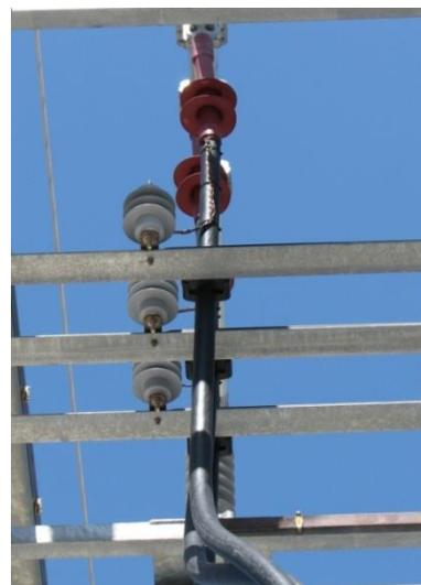
Figura 7 - Pormenor de ligação do DST de blindagem no barramento MT junto ao TP
