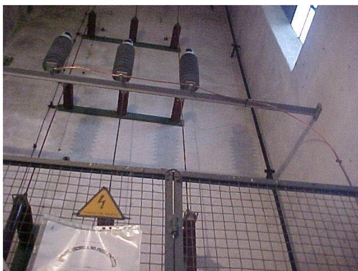
Figura 13 - Montagem de DST no interior de PTCA (afastado do transformador). Exemplificativo
