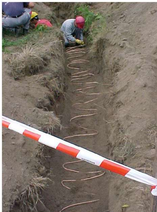
Fig. 5.4.4 – Ligação do eléctrodo de terra – serpentina dupla
