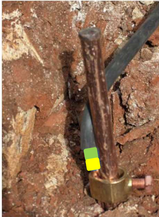
Fig. 5.4.1 – Ligação do eletrodo de terra – vareta simples ou extensível
