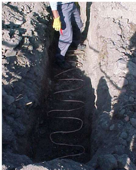
Fig. 5.4.3 – Ligação do elétrodo de terra – serpentina simples
