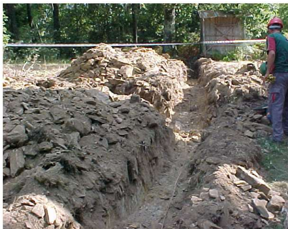
Fig. 5.4.6 – Ligação do elétrodo de terra – estrela
