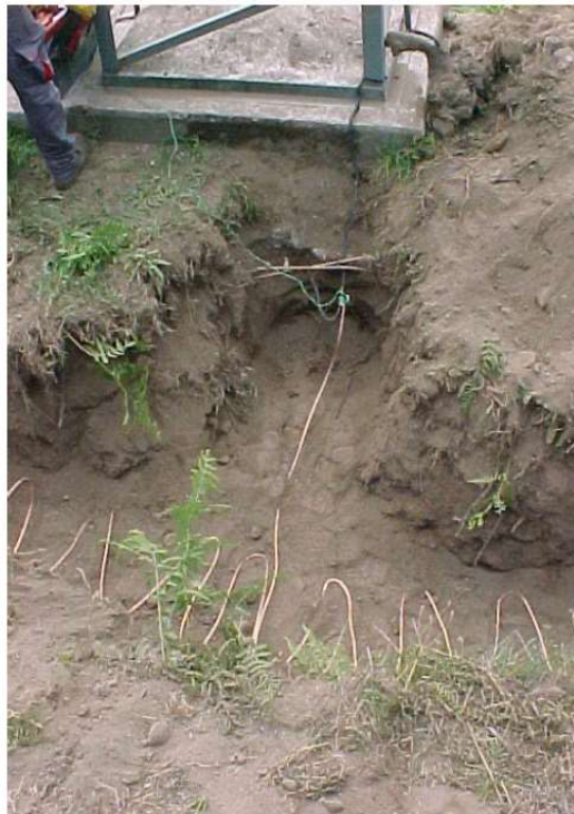
Fig. 5.4.5 – Ligação do elétrodo de terra – serpentina dupla longa
