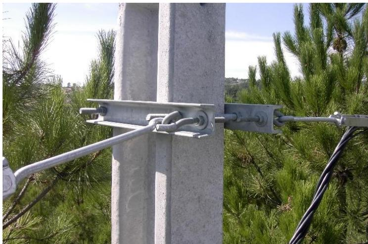
Fig. 4 – Pormenor da ferragem para fixação apoio de MT
