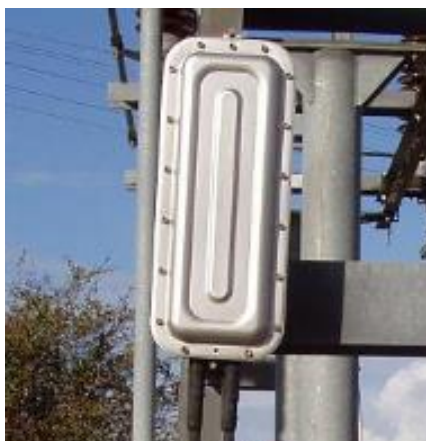
Figura 1 – Caixa Fusão Aérea Terminal 24 FO (exemplo).
