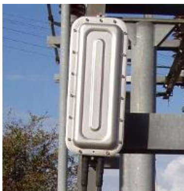
Figura 1 – Caixa Fusão Aérea Terminal 48 FO (exemplo).
