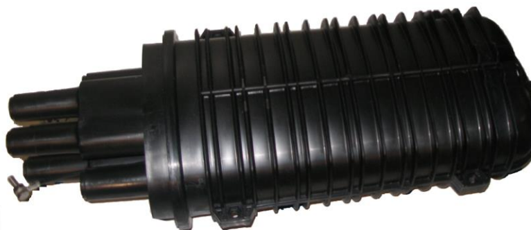
Figura 1 – Caixa de fusão subterrânea para suporte de 24 fusões de fibras óticas (exemplo).
